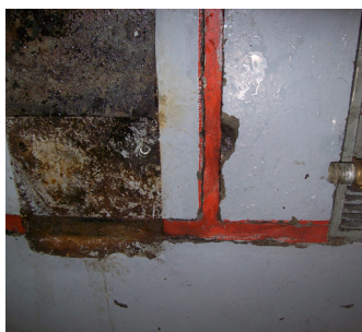
劣化的接缝
