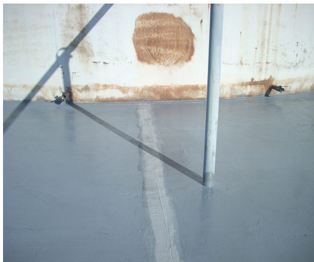
用于在隔离区翻新失效接缝
