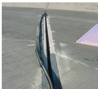
受损的接缝
