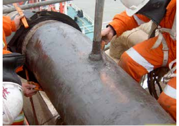
油和热水管道修复
