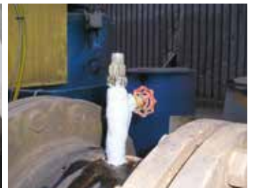
管道泄漏密封
