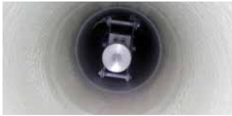
将贝尔佐纳(Belzona) 1381 旋转喷涂于管道内的施工前、施工期间与施工后。
