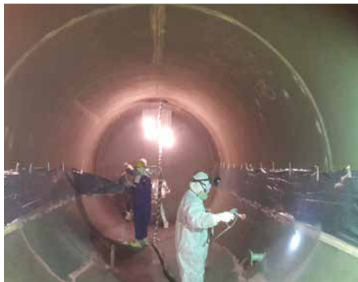
已喷涂贝尔佐纳(Belzona) 1391S
