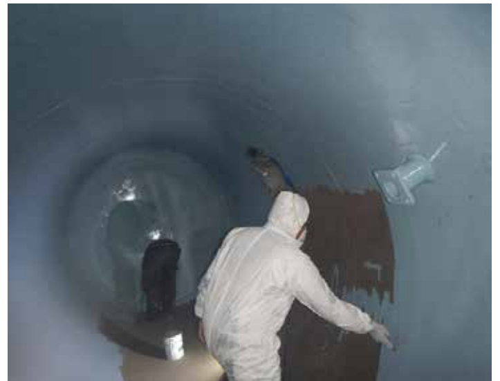
已手工敷涂贝尔佐纳(Belzona) 1391T
