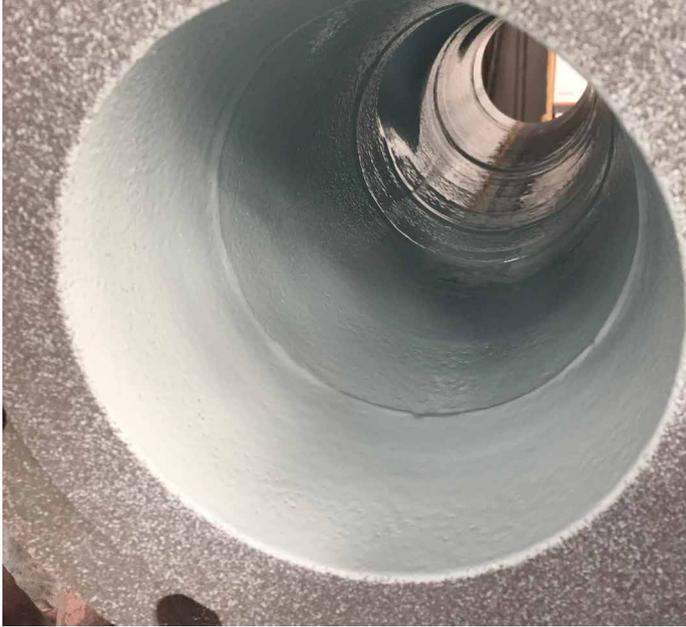
贝尔佐纳(Belzona) 1523 具有持久的耐腐蚀性和耐化学性,适用于在温度高达 140°C (284°F) 的连续浸泡环境中运行的设备。这一喷涂涂层的复涂时间为 24 小时,便于快速有效地完成大型施工,且显著缩短停工时间。
