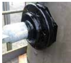
变压器泄漏密封
