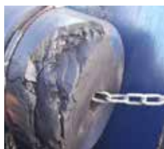
受损部位已修复
