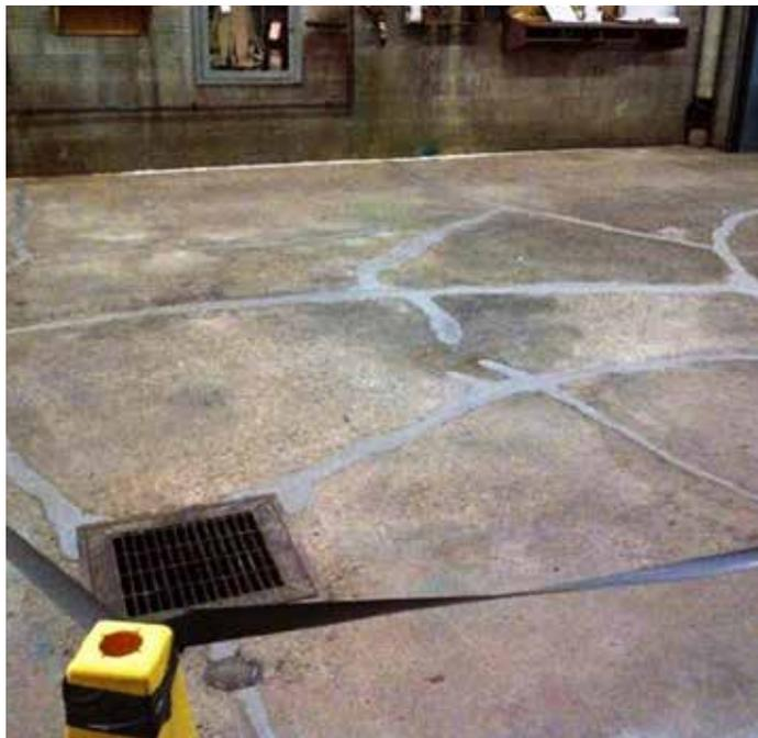
使用贝尔佐纳(Belzona) 4151 和 4111 系列完成了裂缝修复
