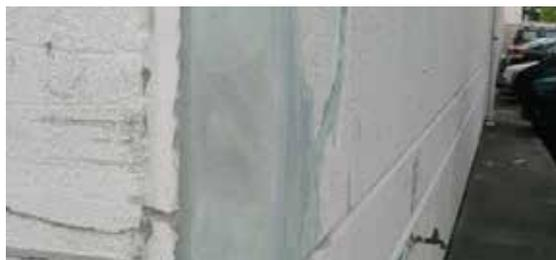
先浇筑贝尔佐纳(Belzona) 4151, 然后使用贝尔佐纳(Belzona) 4111 填充裂缝
