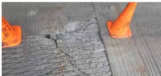
一块混凝土板开裂造成道路问题
