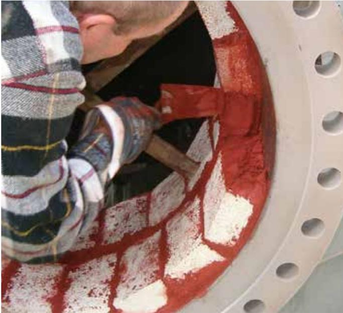
贝尔佐纳(Belzona) 4181 (AHR乳浆石英) 是一种耐酸、耐热性涂层系统, 适用于为遭受冲击、磨损和化学侵害的混凝土、石材和其他刚性基材提供修复和保护。
