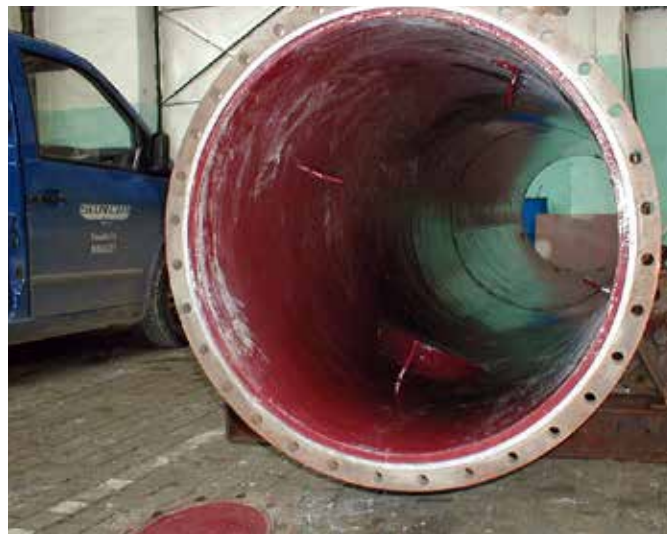
为化学反应塔再施工一层保护层
