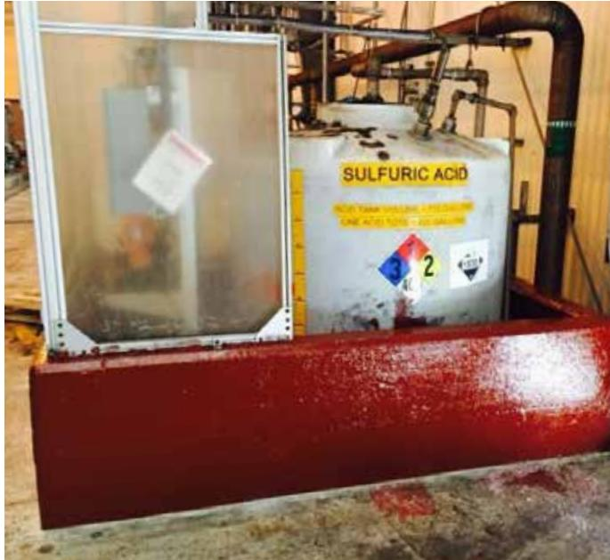
贝尔佐纳(Belzona) 4361 是一种为化学污染区提供保护的弹性防护涂层。
