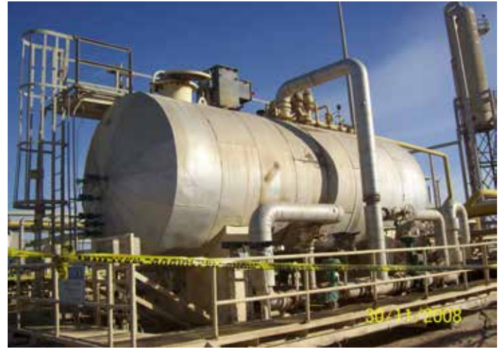
使用贝尔佐纳 (Belzona) 5892 为淡化器敷涂内衬
