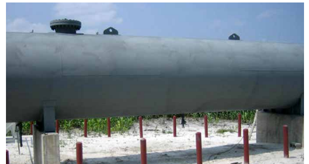
在容器上涂装贝尔佐纳 (Belzona) 6111, 为金属表面提供阴极保护
