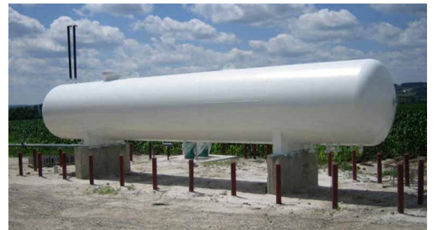
加涂贝尔佐纳 (Belzona) 5111 完成施工, 提供更进一步的保护
