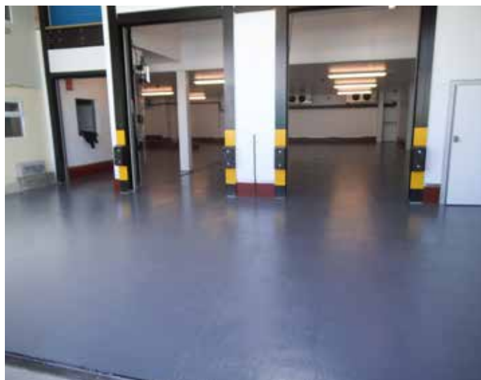
使用贝尔佐纳 (Belzona) 5231 修复牛奶厂仓库地面
