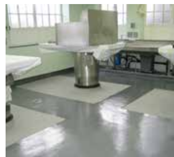
混凝土地面修复后
