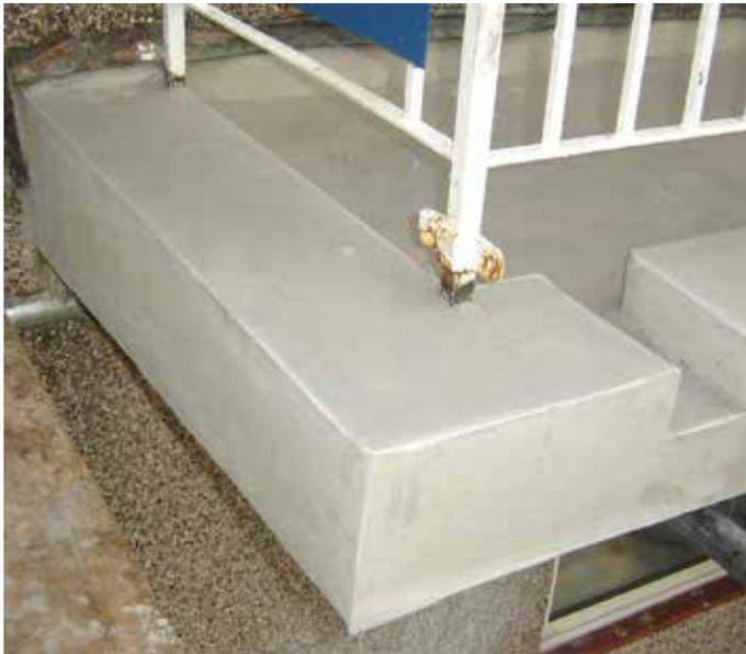
贝尔佐纳(Belzona) 4111 (乳浆石英) 是一种多用途修复复合材料, 适用于对混凝土和石材进行表面重修、重建和保护。
