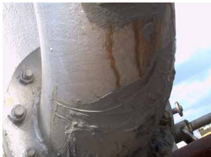
贝尔佐纳 (Belzona) 4301 用于将钢板粘接到受化学侵蚀的管道上
