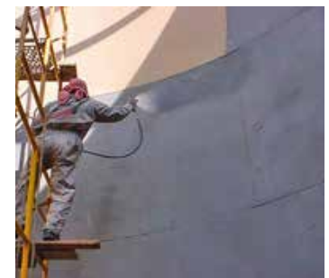
为储罐敷涂内衬
